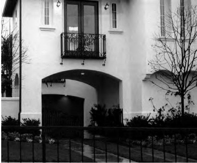
ABOVE PORTE COCHERE
